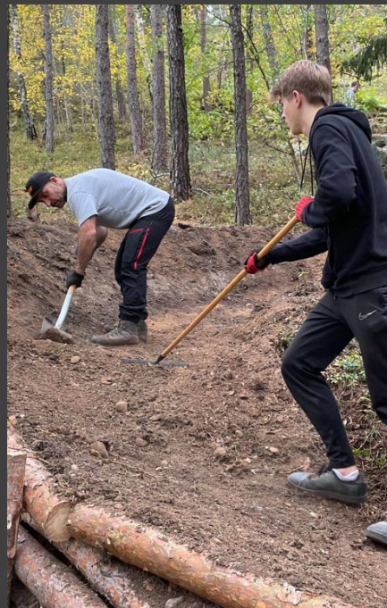
Arbete pågår på nya dragningen av DH-Race
